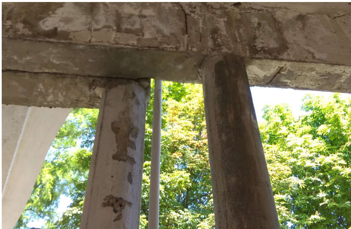
Zdjęcie 7: Uszkodzona otulina na słupach
