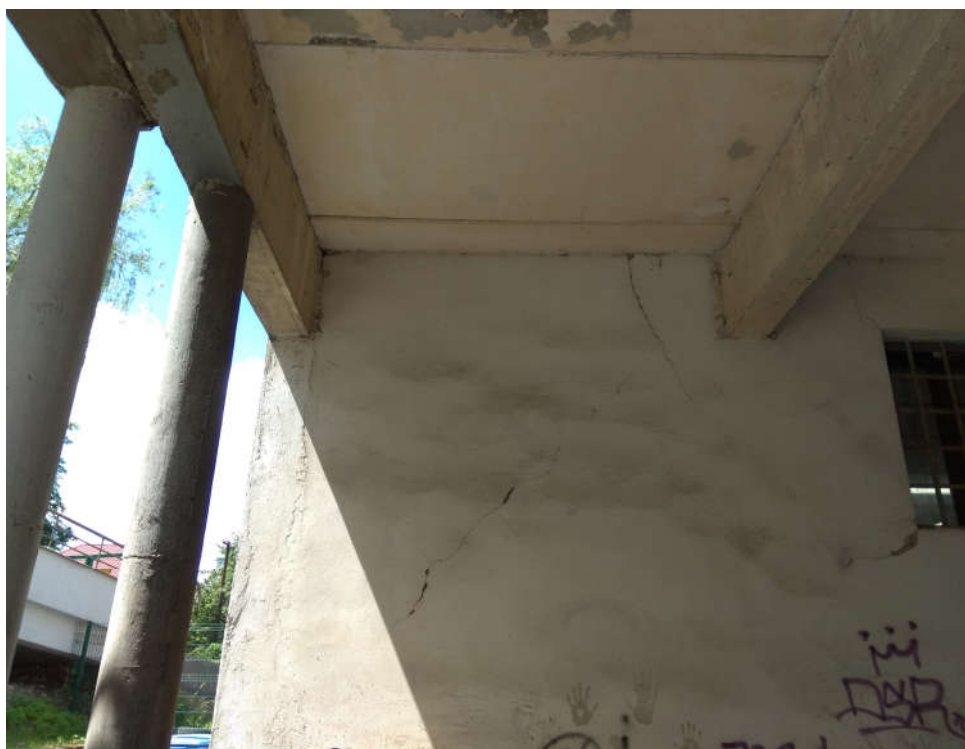
Zdjęcie 20: Peknięcia na ścianach – dolna kondygnacja
