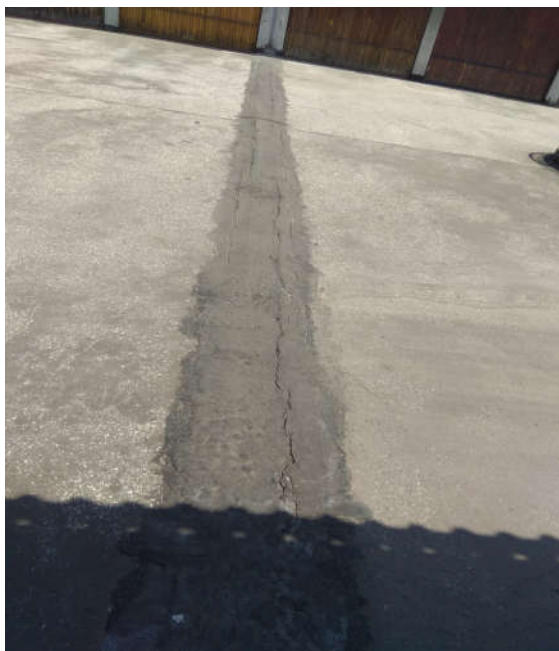
Zdjęcie 13: Próba naprawy dylatacji skrajnej
