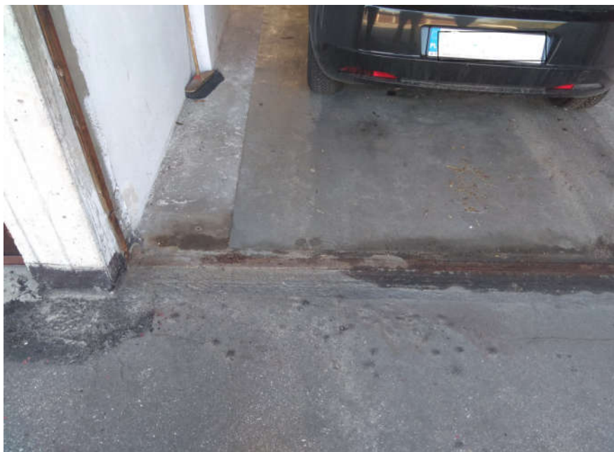
Zdjęcie 18: Uszkodzone progi garażowe
