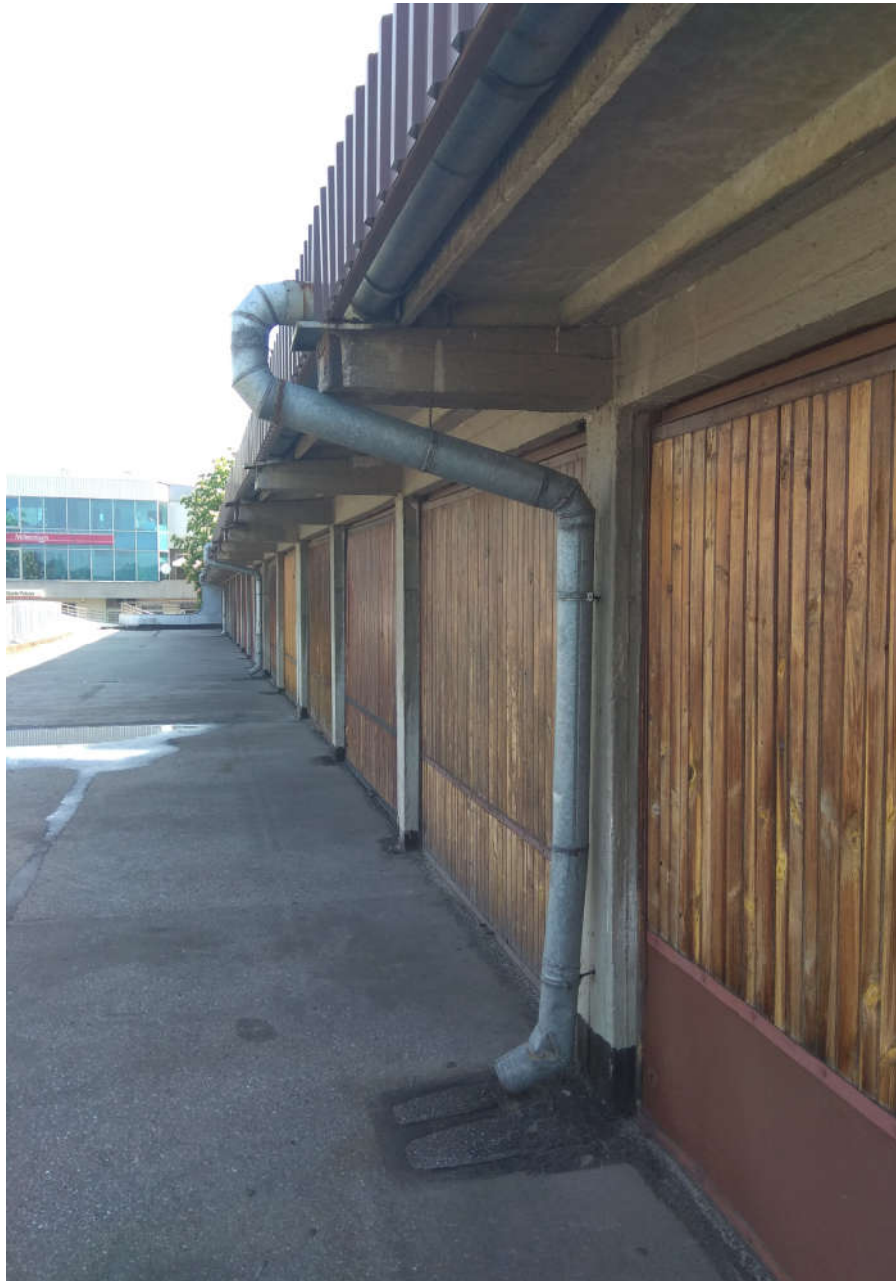
Zdjęcie 17: Odprowadzenie wód opadowych z ostatniej kondygnacji bezpośrednio na górną płytę.
