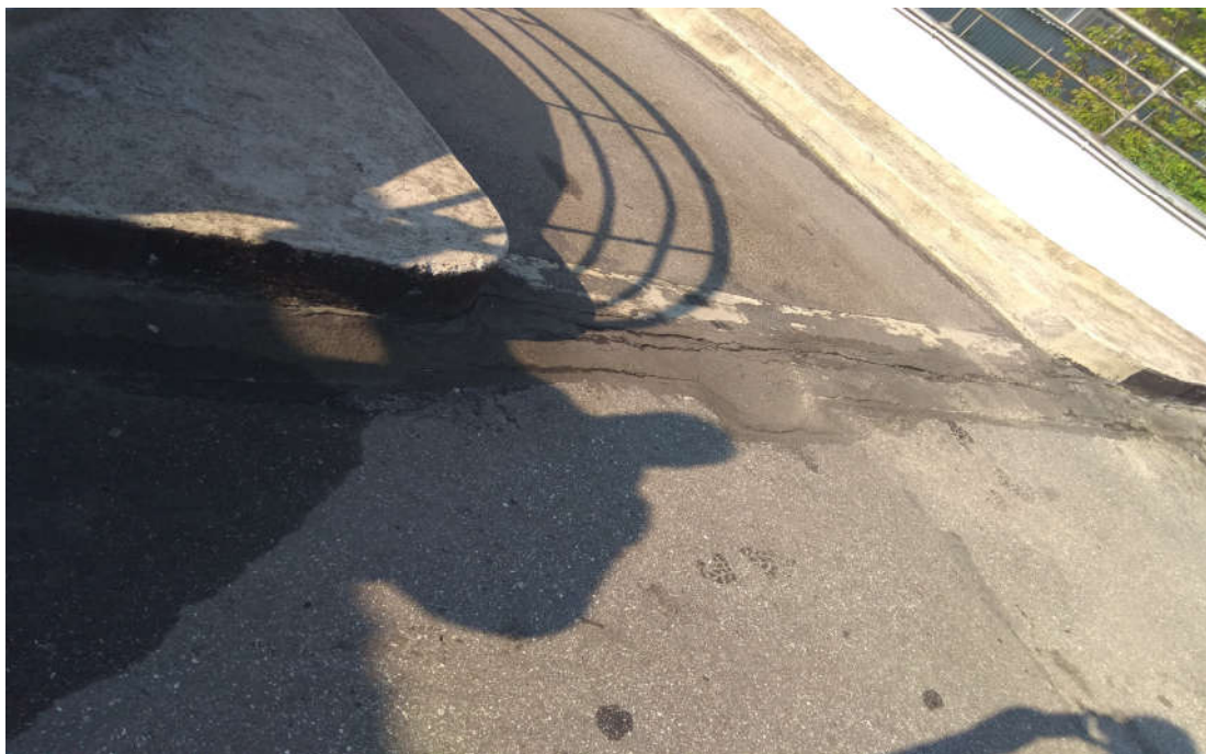
Zdjęcie 13: Próba naprawy dylatacji skrajnej
