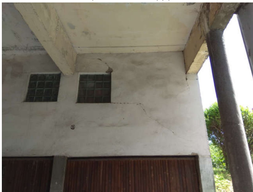
Zdjęcie 19: Pęknięcia na ścianach – dolna kondygnacja
