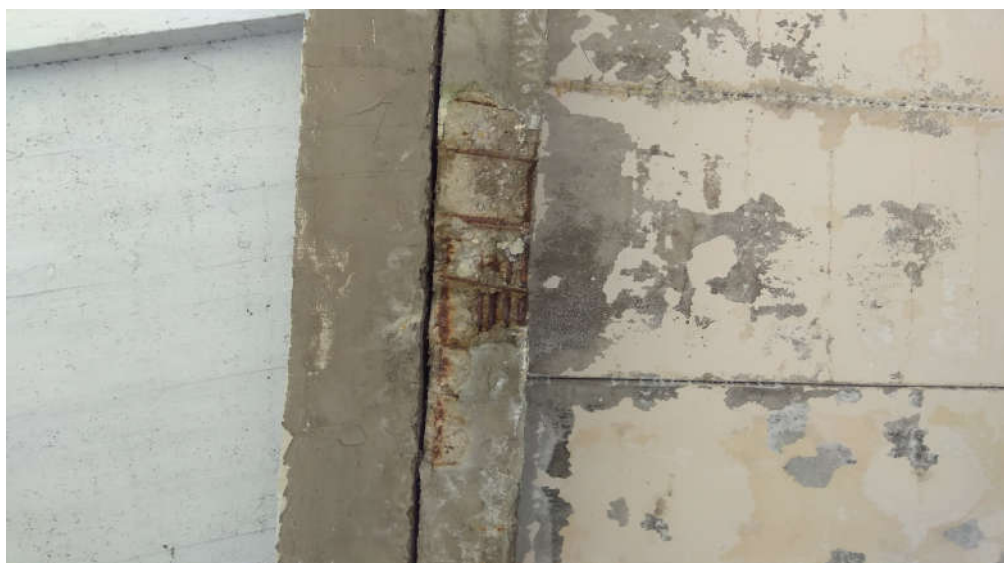
Zdjęcie 4: Widoczne odsłonięte i skorodowane zbrojenie, brak otuliny.
