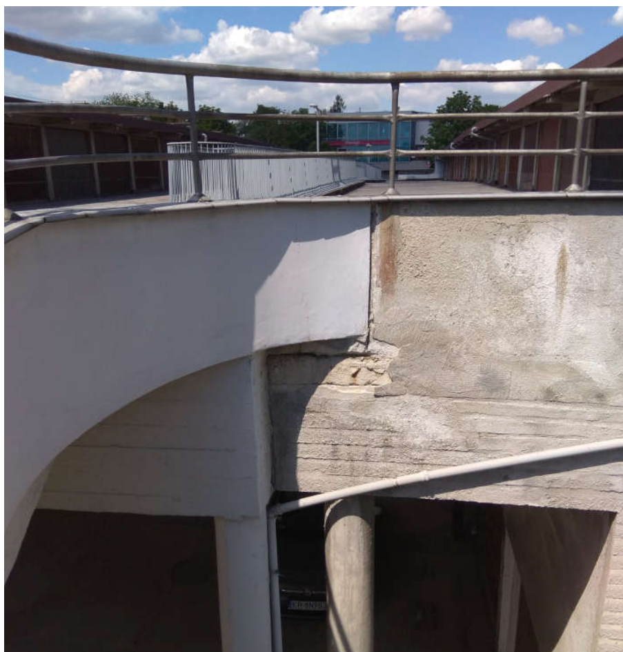
Zdjęcie 12: Odpadający tynk pod dylatacją
