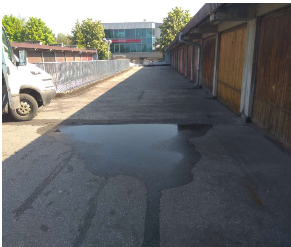
Zdjęcie 9: Brak spadku, naprawa dylatacji zniszczyła ukształtowanie spadków– uszkodzone odwodnienie
