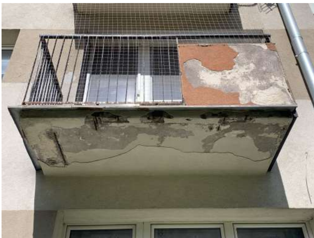
Fot. 4 – płyta balkonowa w złym stanie technicznym – prawie całkowite odpadnięcie tynku z dolnej powierzchni balkonu, liczne ubytki w betonie, uwidocznione zbrojenie
