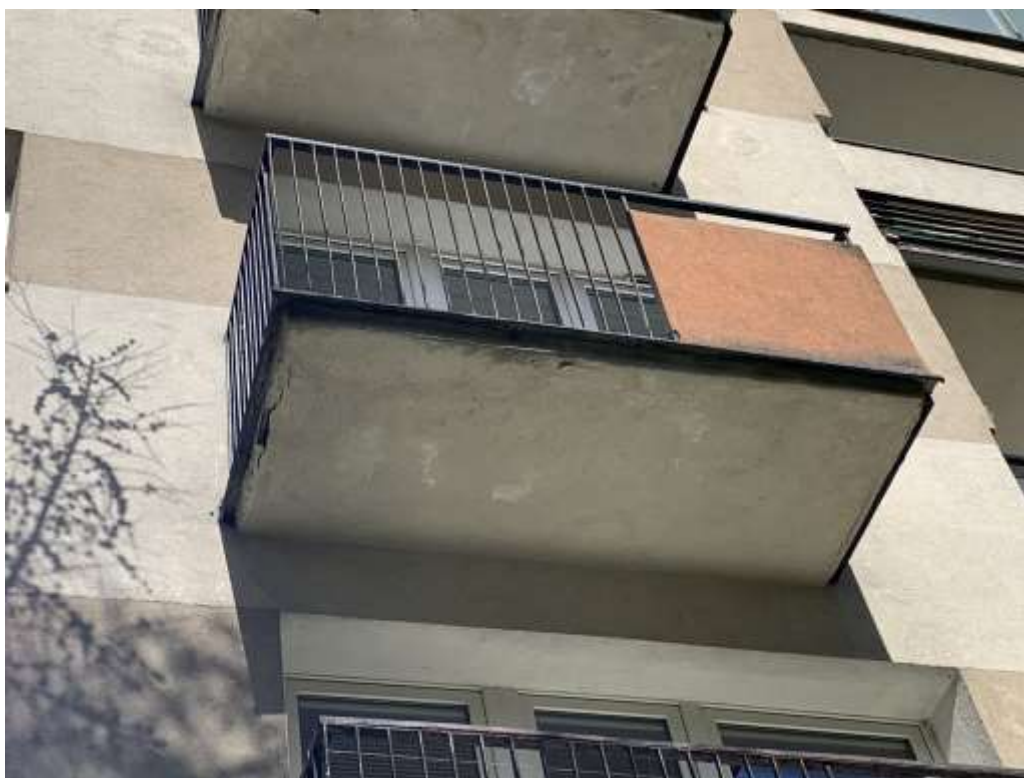
Fot. 2 – dolne powierzchnie płyt balkonowych z widocznymi niewielkimi odpryskami tynku
