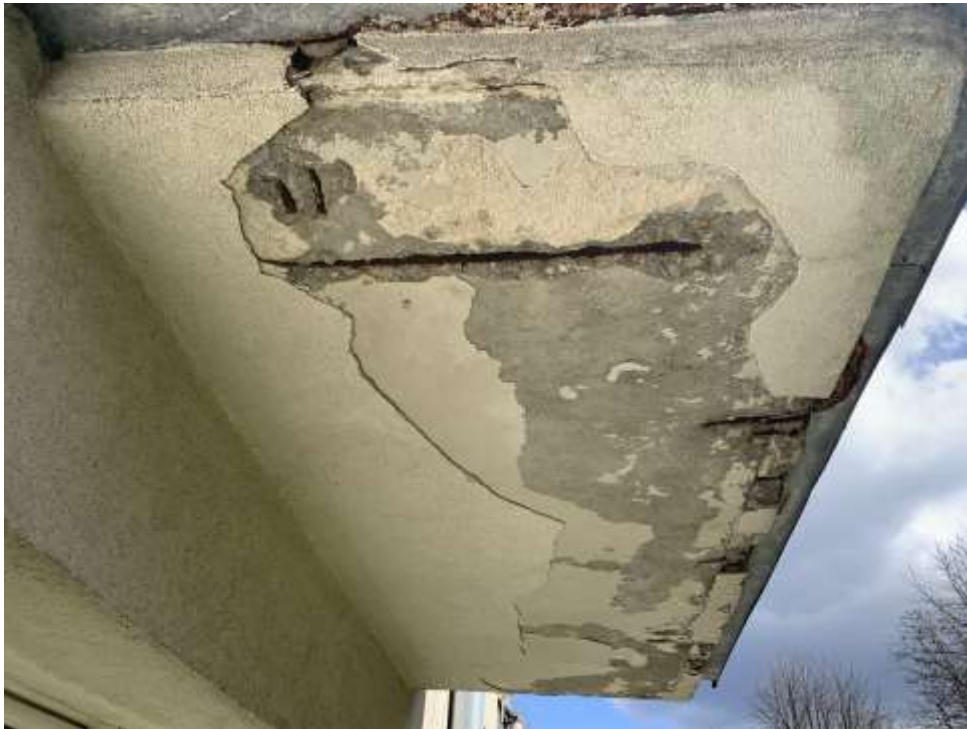
Fot. 5 – płyta balkonowa w złym stanie technicznym – prawie całkowite odpadnięcie tynku z dolnej powierzchni balkonu, liczne ubytki w betonie, uwidocznione zbrojenie
