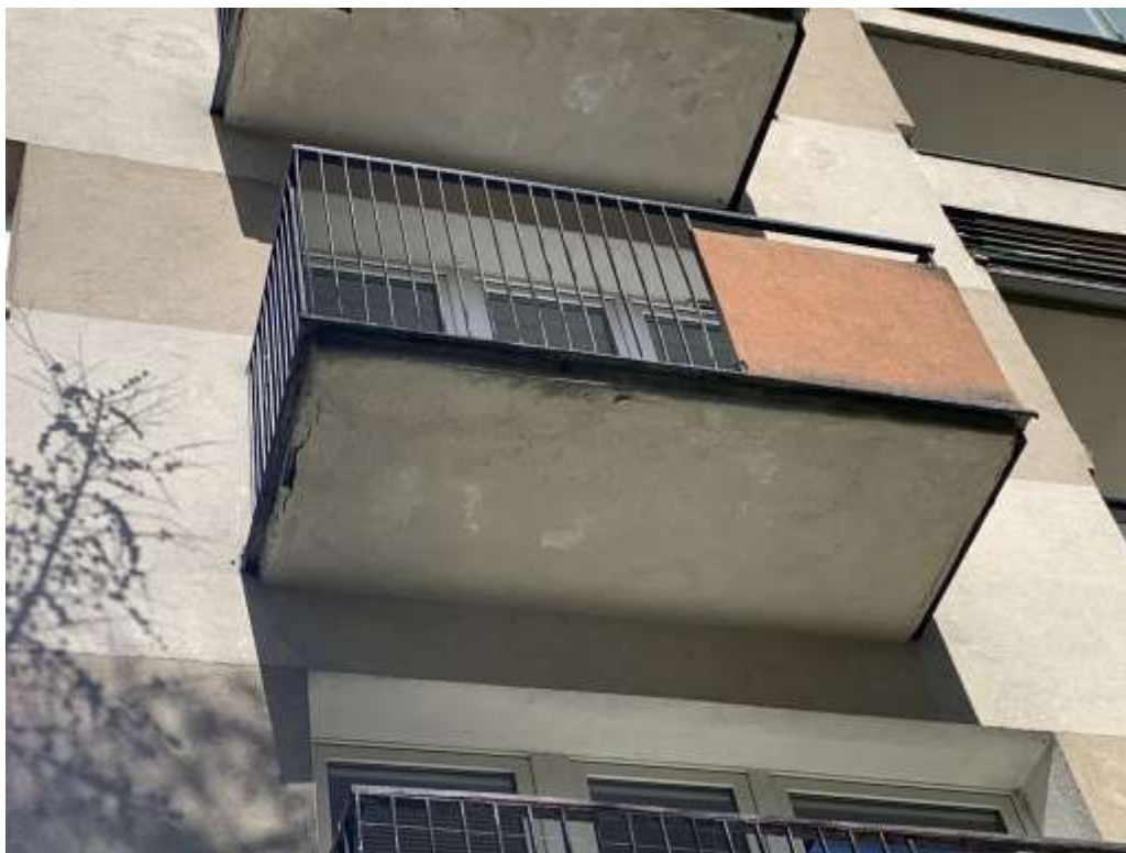
Fot. 2 – dolne powierzchnie płyt balkonowych z widocznymi niewielkimi odpryskami tynku
