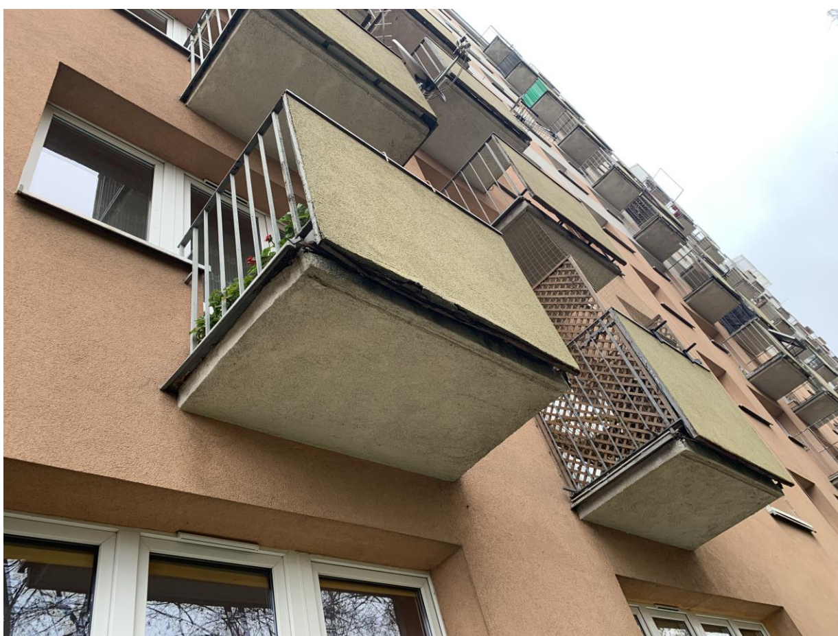
Fot. 4 – odparzony tynk wypełnienia balustrady balkonu i niewielkie ubytki płyty balkonu
