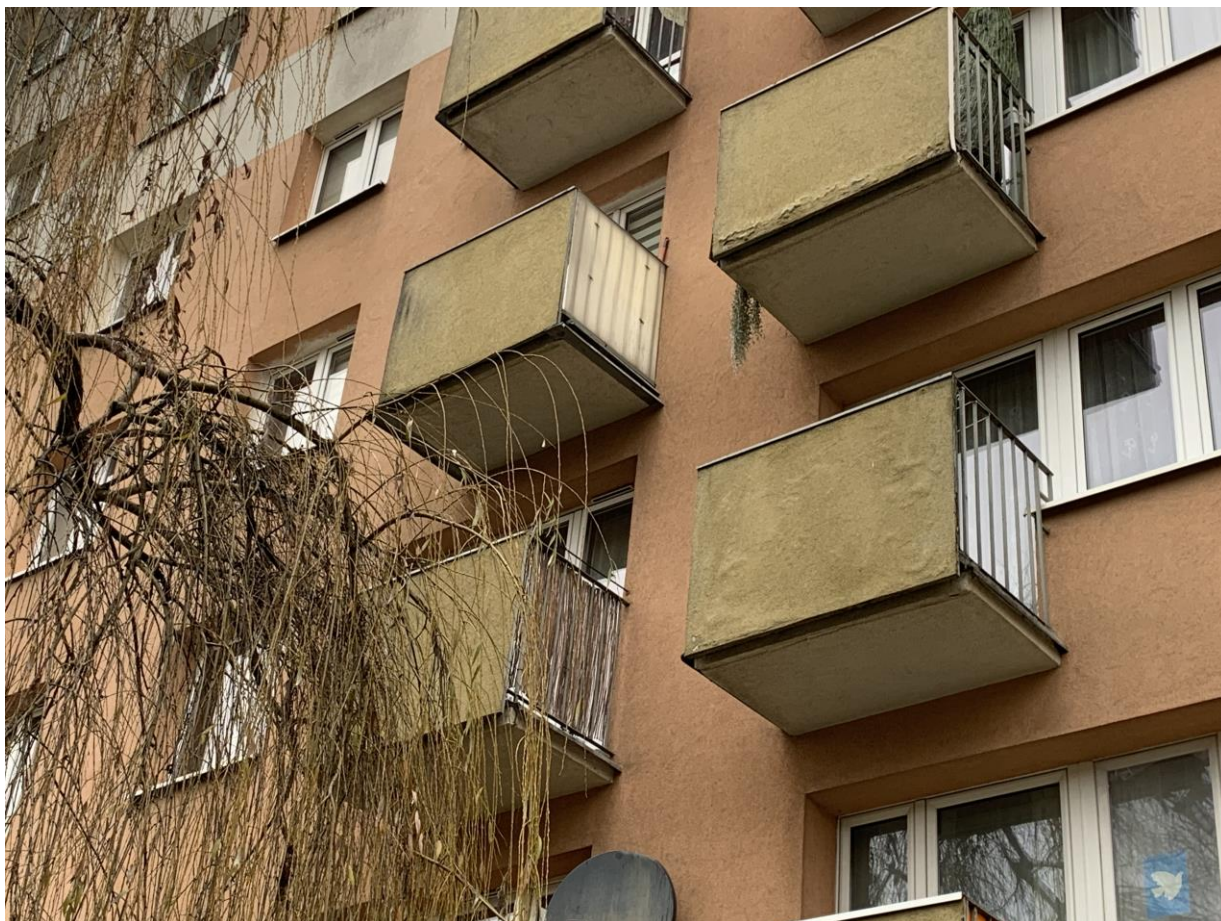
Fot. 3 – odparzony tynk wypełnienia balustrady balkonu
