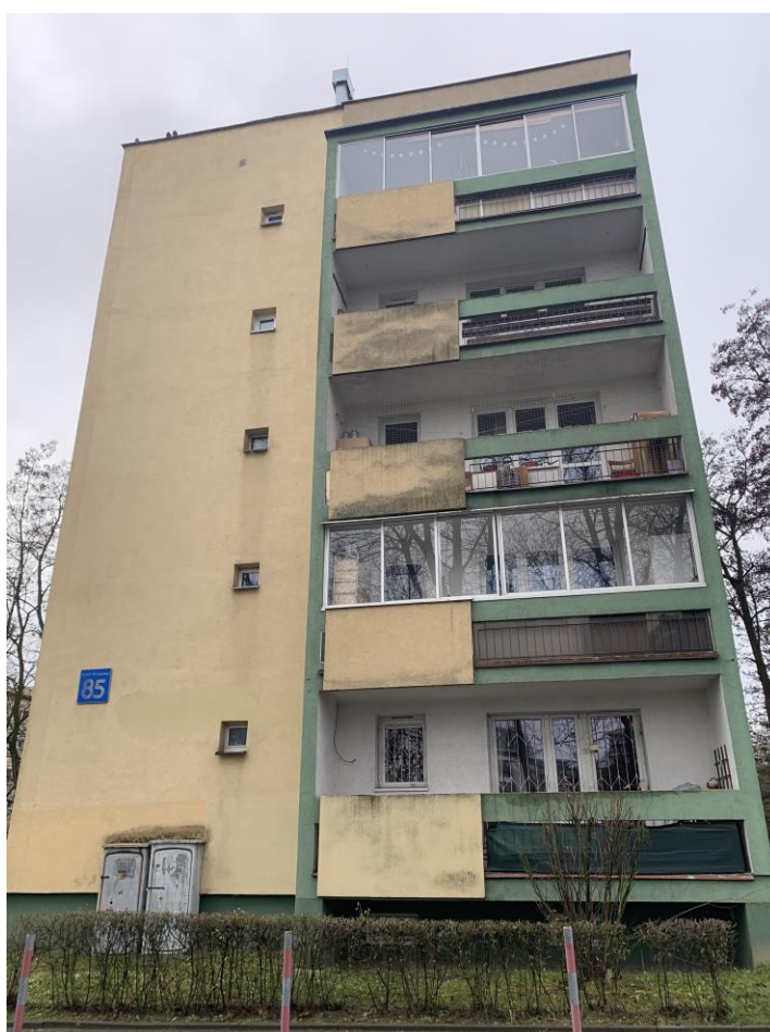
Fot. 7 – widok zacieków na płytach elewacyjnych balkonów i belce balkonowej
