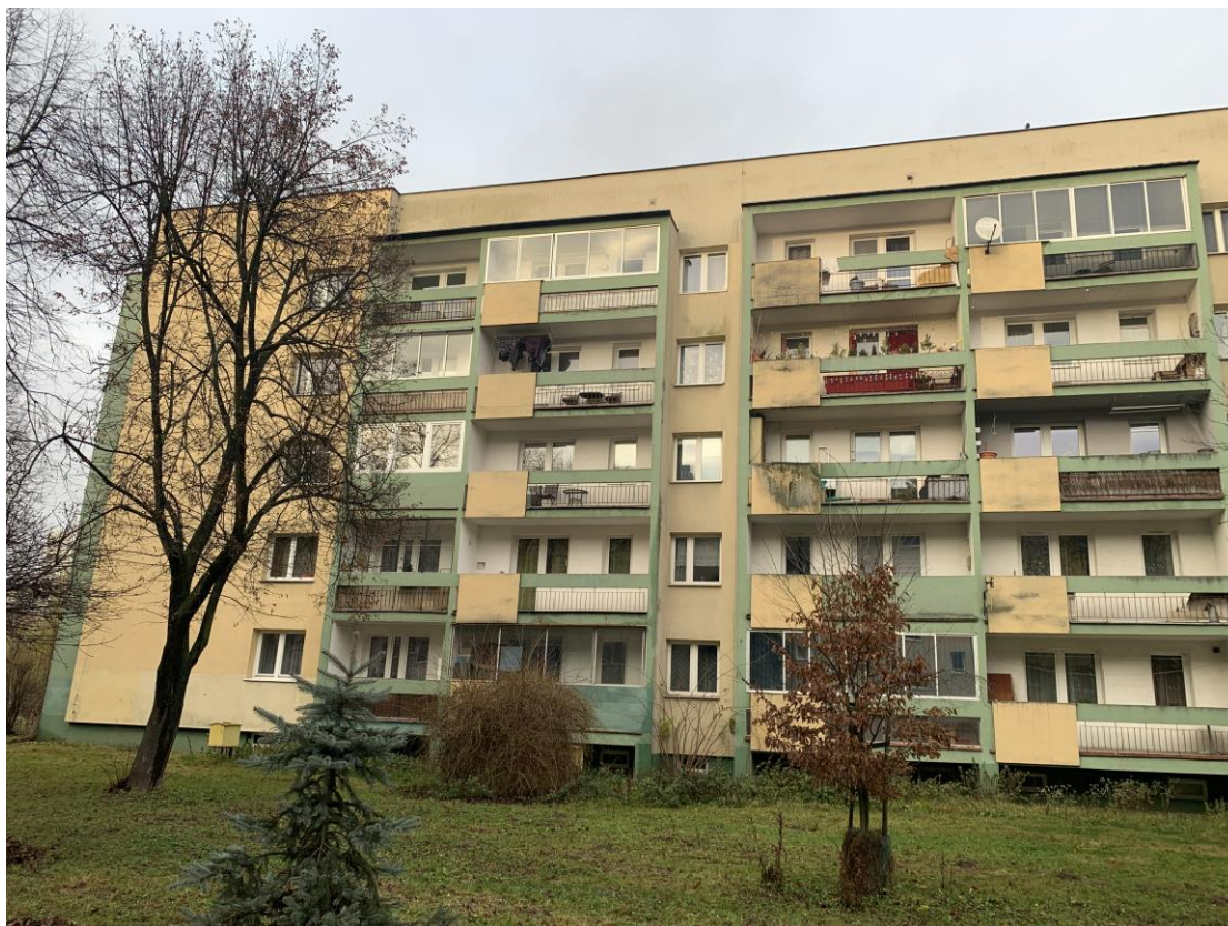
Fot. 7 – widok zacieków na płytach elewacyjnych balkonów i belce balkonowej
