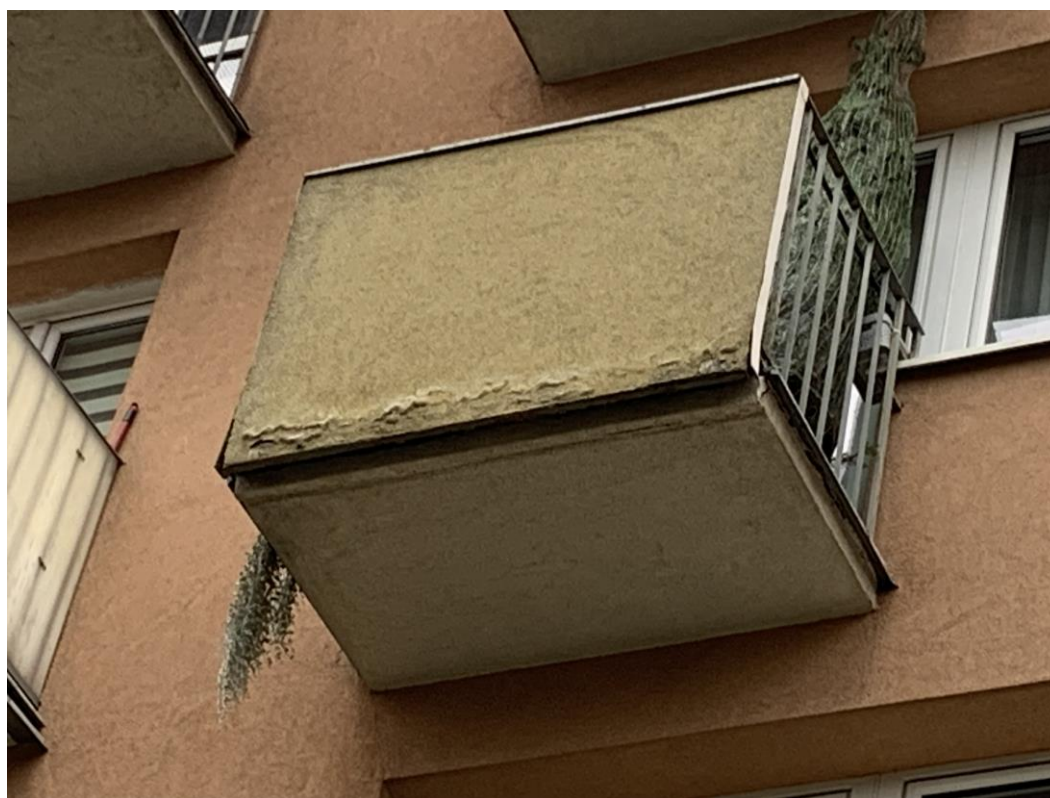
Fot. 2 – odparzony tynk wypełnienia balustrady balkonu
