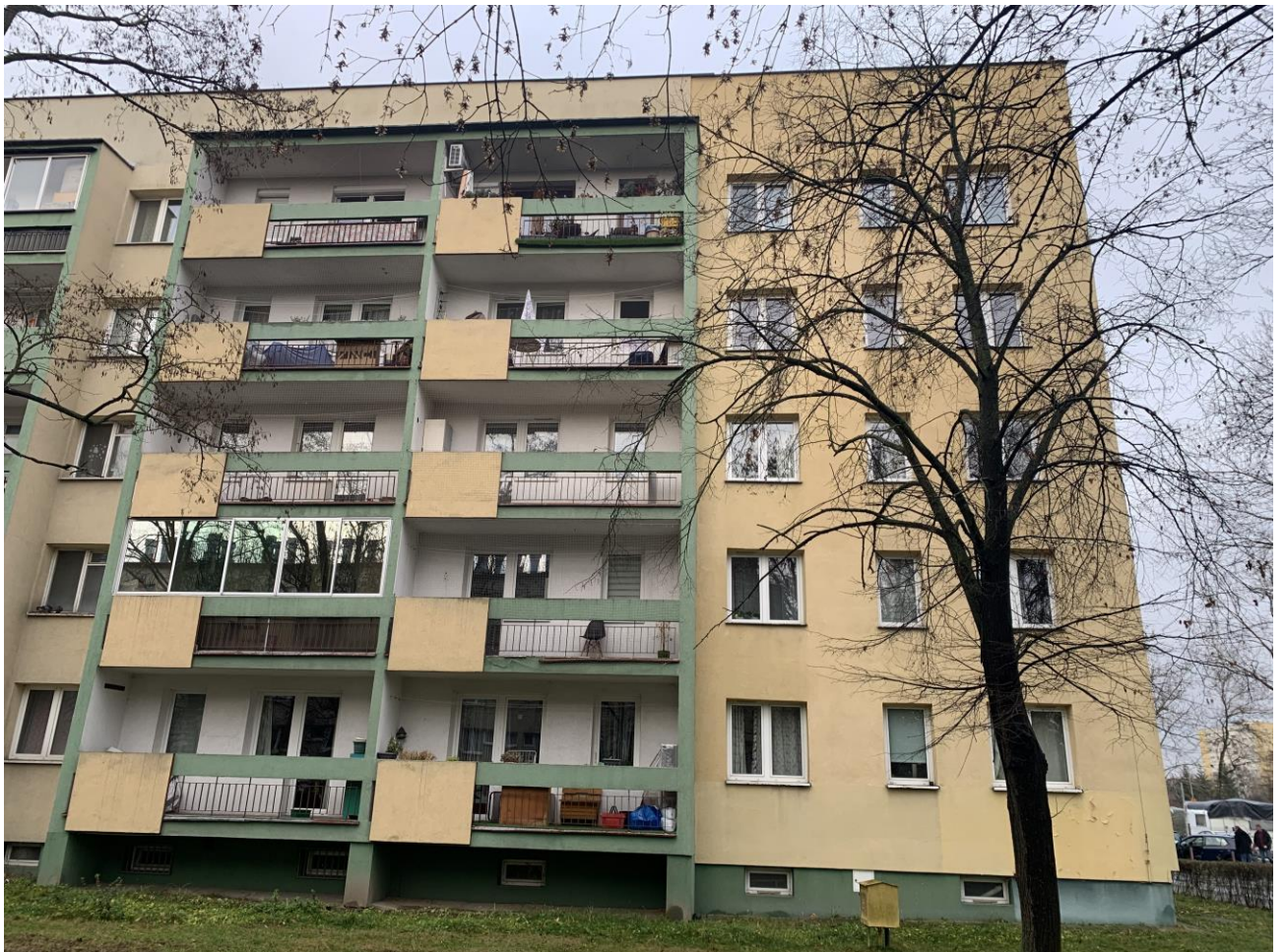
Fot. 6 – widok zacieków na płytach elewacyjnych balkonów i belce balkonowej
